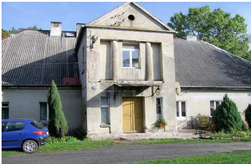
Dworek w Dobieszewicach / wejście od frontu /
