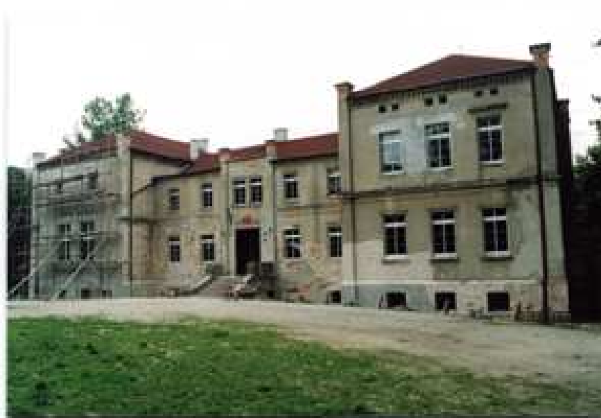
Szkoła Podstawowa w Broniewicach / przed remontem /
